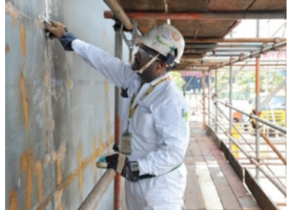
Rajah 6 Platform kerja dengan rel penghadang dan papan "toe-boards" dipasang
